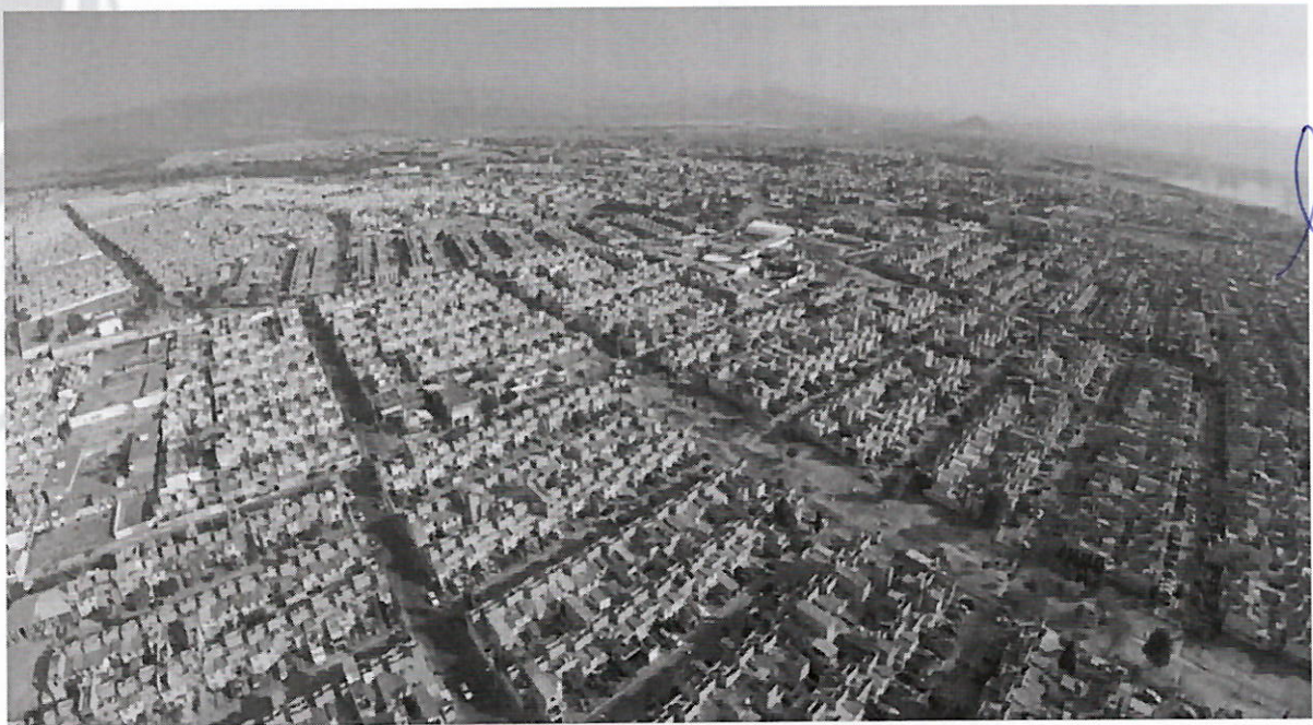
Unidad Habitacional vista área. Cuenta con 7 secciones habitacionales.
